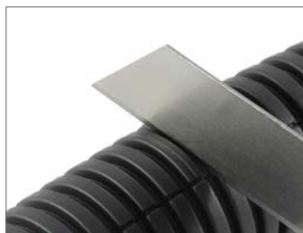
Krácení chráničky na požadovanou délku
